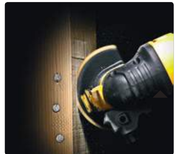
Cortar madeira de construção ▲
