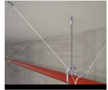
Refuerzo sísmico con cable – Página 381 –
